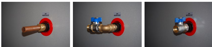
Obr. 12. Správne pripojenie nádrže tepelného čerpadla k vodnej inštalácii budovy pomocou konektorov elektrickej izolácie.
